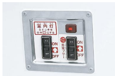
㉓ 非常警報装置
