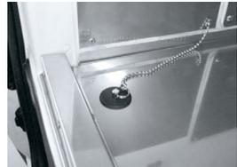
サイドドア部に25mmの水止めを設置し、水抜き穴を追加します。
